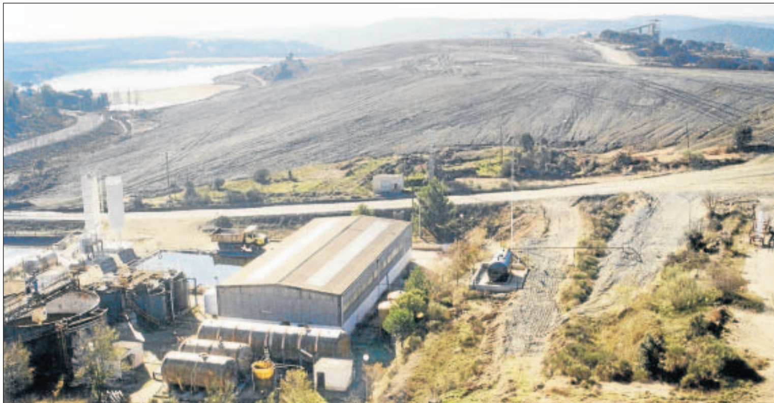
Antiguas instalaciones mineras en Sahelices el Chico durante la explotación de Enusa.
